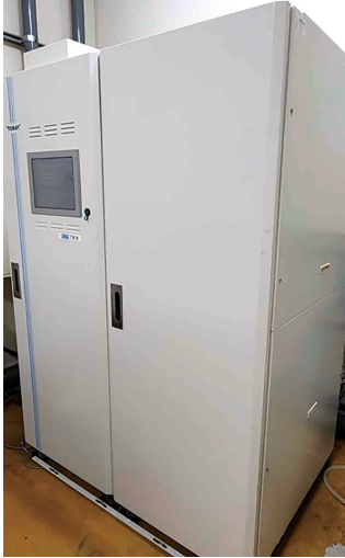
【図】RO水を作るための装置
